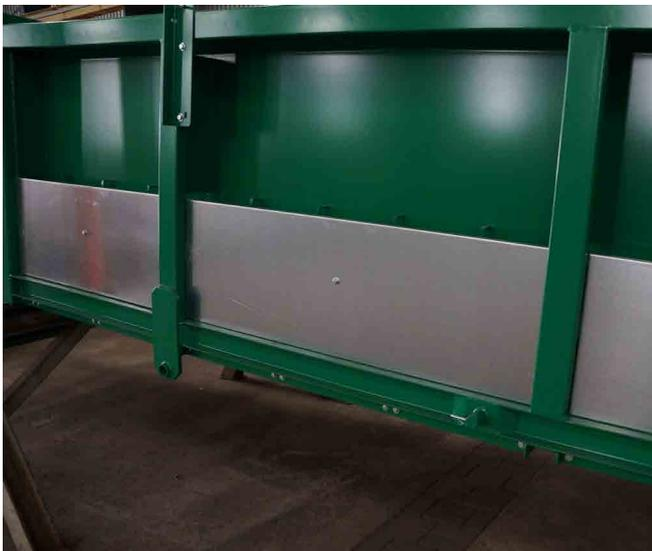
Verkleidung der Profilstahlkonstruktion aus verzinktem Blech – schnell demontierbar
